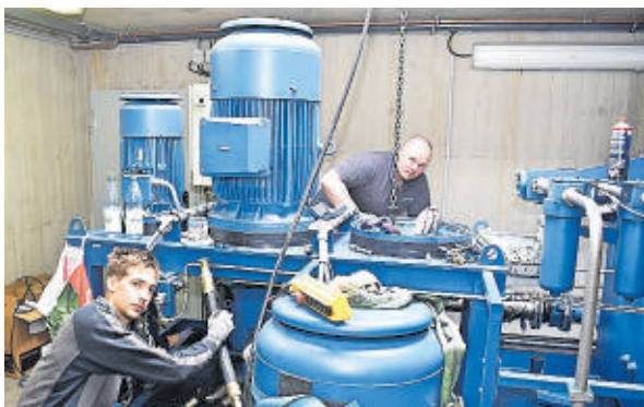
Marcel Niemeyer und Dennis Hüttemeyer von der Firma Eska tauschen die Hydraulikpumpen aus (von links).
