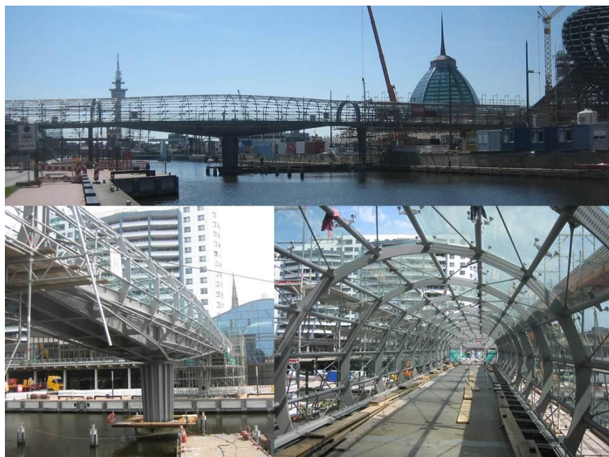
Abb. 18: Hafendrehbrücke Bremerhaven, Tragwerk, Bauzustand
