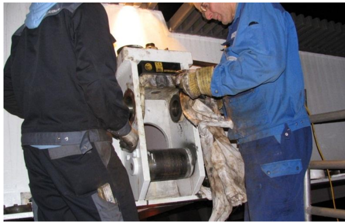
Abb 25: Wartung einer Verriegelung
