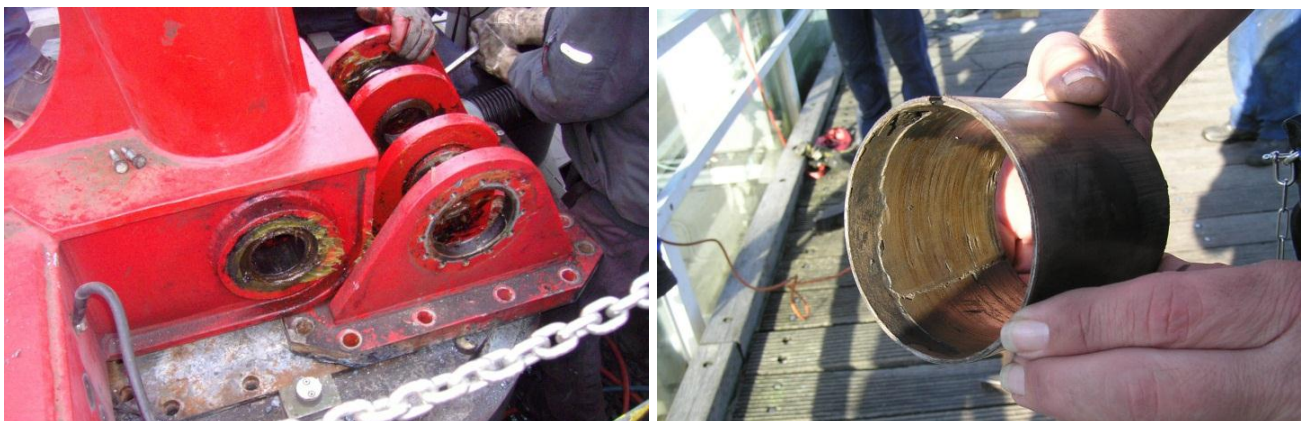
Abb. 28: Austausch Gleitlager, Buchse mit zerstörter Gleitfläche
