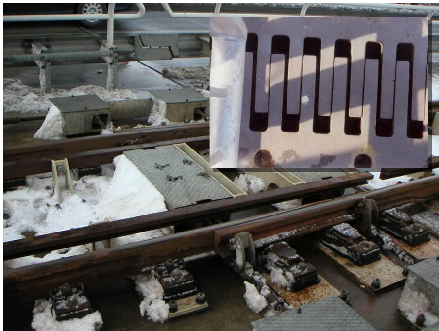
Abb. 16: Übergänge Leitplanke, Fahrbahn, Gleis
