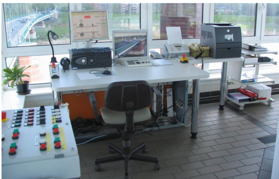
Abb. 20: Steuerstand mit Mosaiktableau, Visualisierung, Videoüberwachung
