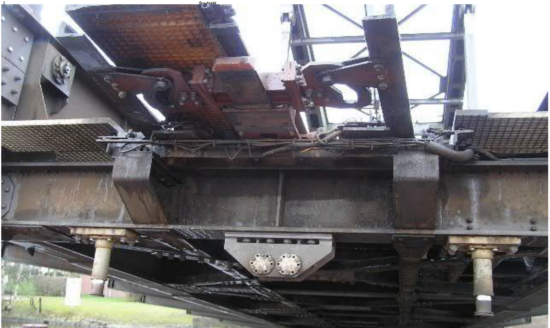
Eisenbahnklappbrücke Emden, Schienenauszug
