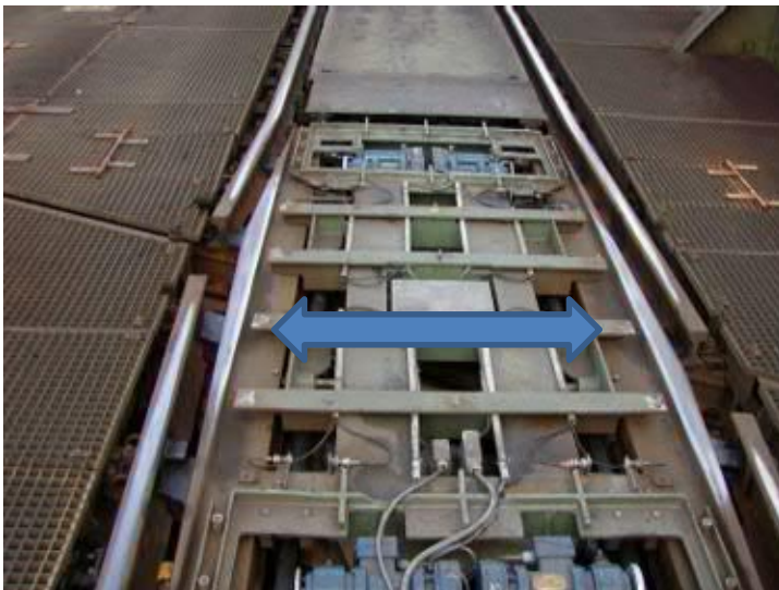
Rollklappbrücke Oldenbrug (2-flügelige Scherzerbrücke) , Schienenauszug (Doppelzungenwagen)
