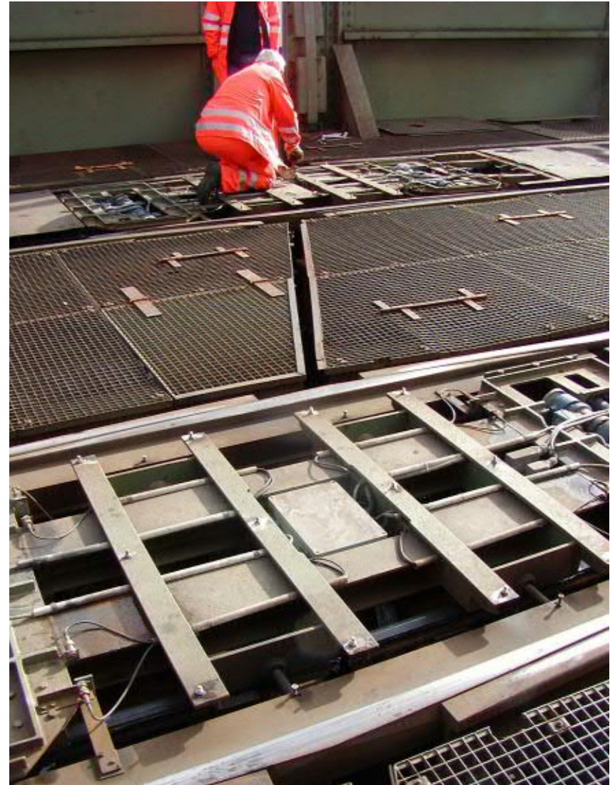
Rollklappbrücke Oldenbrug (2-flügelige Scherzerbrücke) , Schienenauszug (Doppelzungenwagen)
